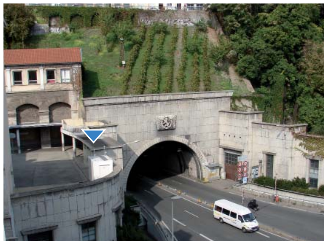
Station de surveillance de la qualité de l'air installée pour 4 ans à la sortie du tunnel de la Croix Rouse
